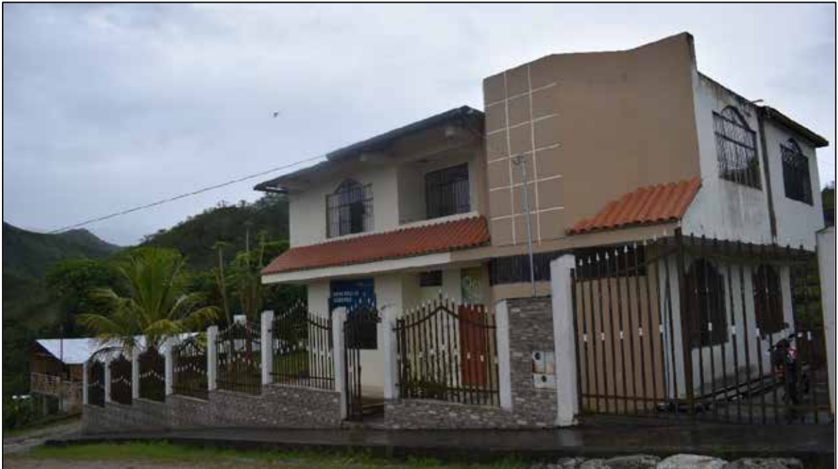
Imagen 20. Aceras y Bordillos Pucapamba.
