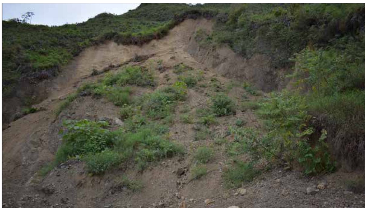
Imagen 24. Deslizamiento Pucapamba - La Balsa.
