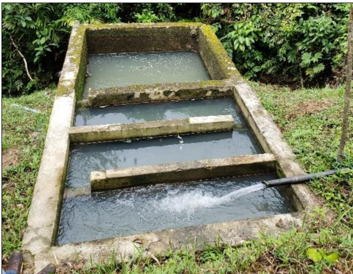
Imagen 1. Captación de Agua para Uso Doméstico de Parroquia Pucapamba.
